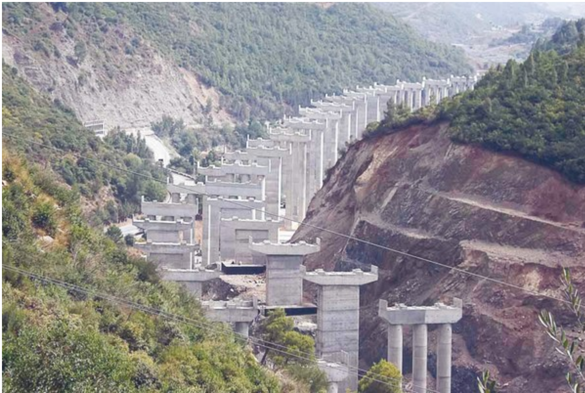
Les 4 viaducs de Ras El-Hamra en cours de réalisation. © D.R.
